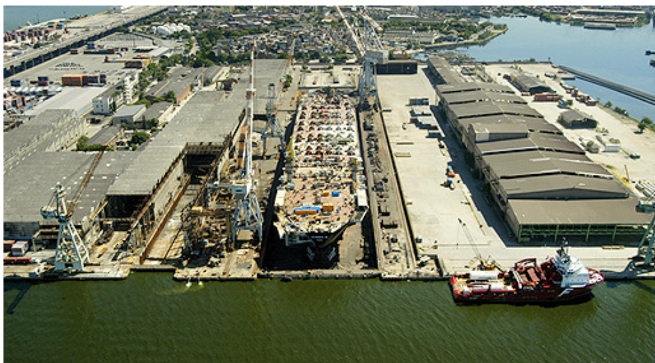
Vista geral aérea do Estaleiro
